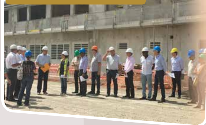
9 DÉCEMBRE - COPIL LYCÉE DU MONT-DORE VISITE CHANTIER
