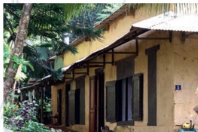
Ancien bâtiment de la Pénitenciaire restauré.
